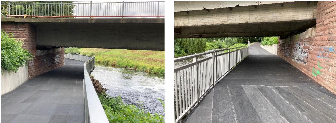
Abbildung 18: Beispiel einer asphaltierten Überkragung in Bad Oeynhausen
